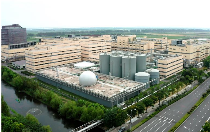
华东医药废水 EPC 总包项目（2021）
